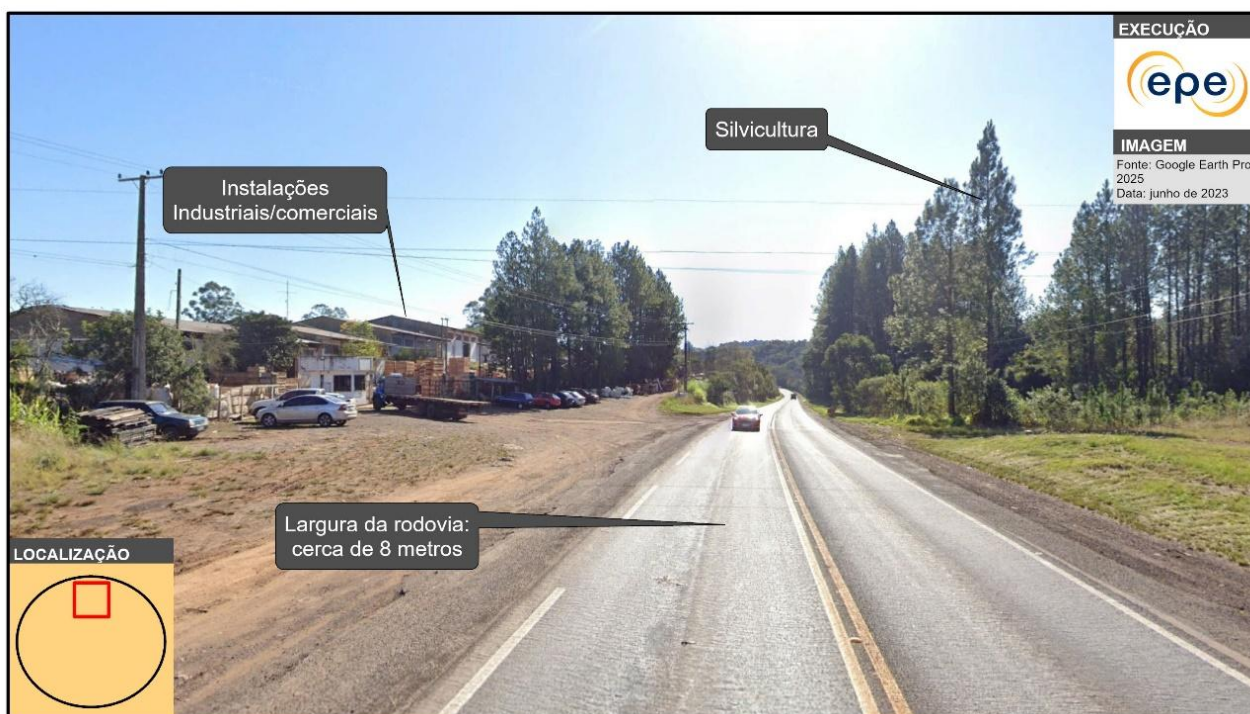
Figura 2 – Detalhe da rodovia BR-158 em trecho pavimentado a sul da cidade de Condor, com instalações industriais às margens
