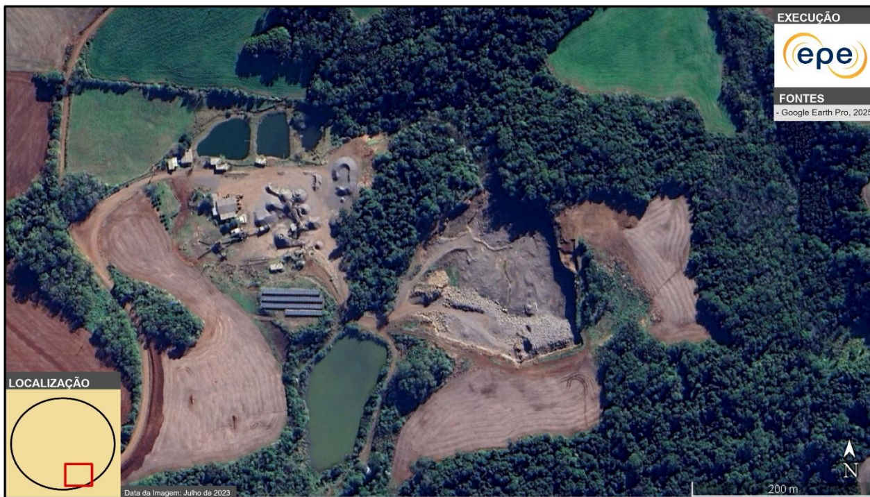
Figura 5 – Cava de mineração em meio a áreas de vegetação nativa, no trecho sudeste da área referencial
